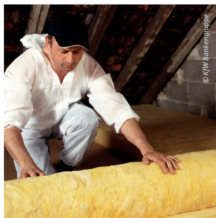
KfW-Zuschüsse für Einzelmaßnahmen begünstigen auch die Wärmedämmung
